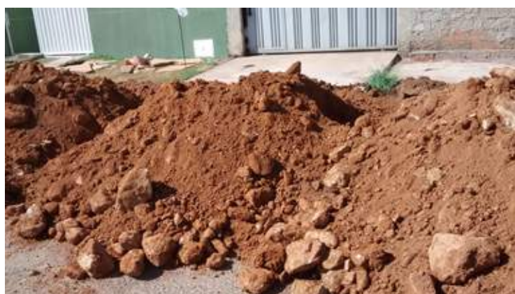
Figura 3 – Vala com material não reaproveitável
