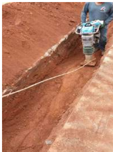
Figura 9 – compactação executada corretamente
