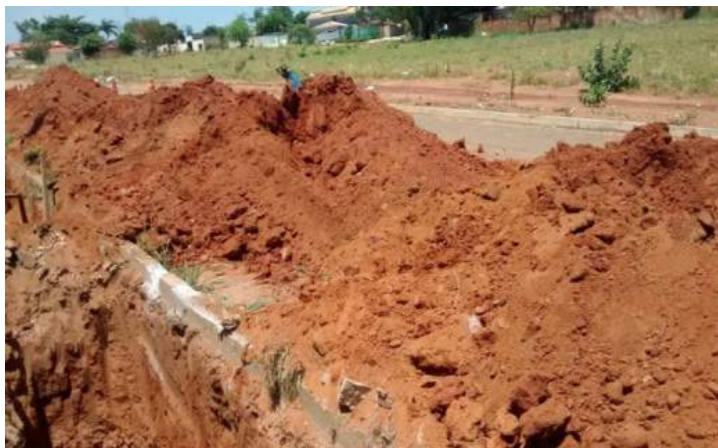
Figura 6 – Vala com material reaproveitável
