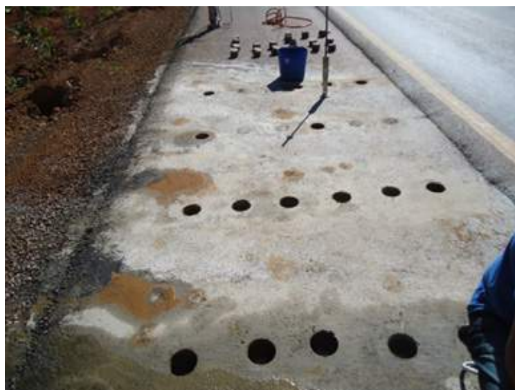
Figura 17 – Local de retirada das amostras na GO-080, trecho: Nerópolis/Entr. da BR-153.
