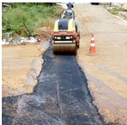
Figura 10 – acabamento com rolo compactador
