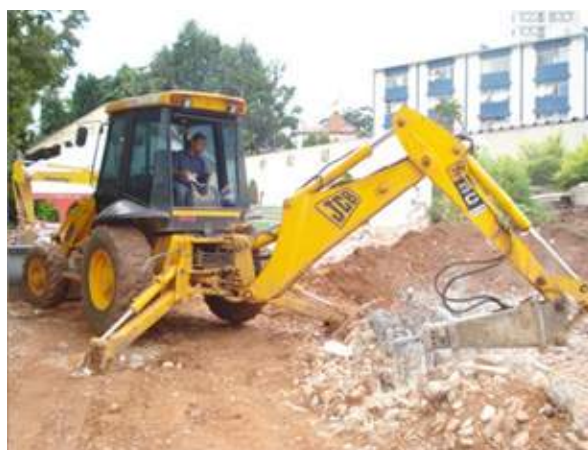
Figura 2 – Exemplo de rompedor
