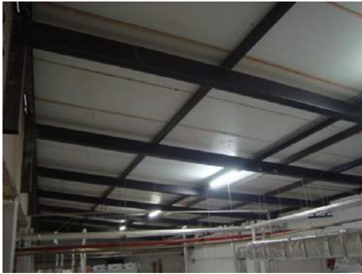
Figura 5 – Execução de estrutura metálica convencional, com custo inferior à estrutura espacial do tipo USI SAC-300 contratada
