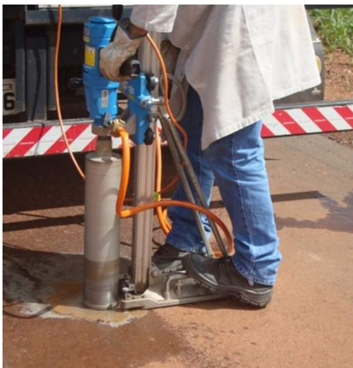
Figura 13 – Sonda Rotativa.
