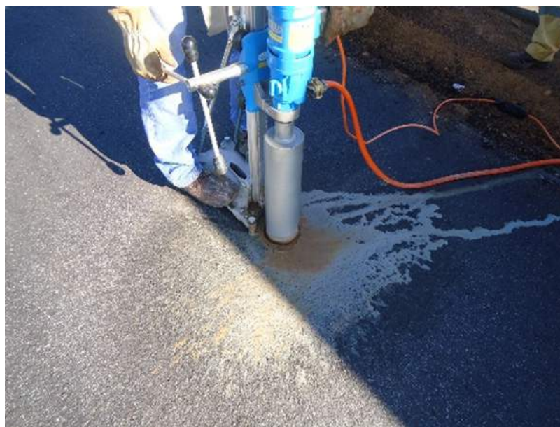
Figura 3 – Extração de corpo de prova utilizando sonda rotativa.
